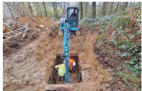
De shelter werd opnieuw dichtgemaakt. Foto RV
